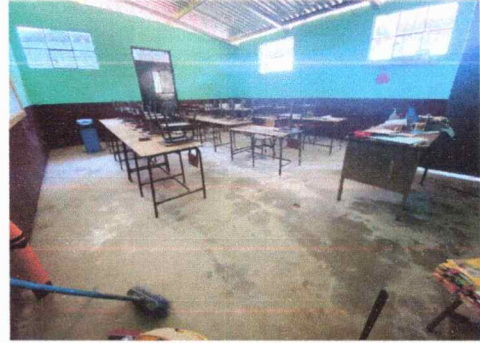
Foto 2: Sustitución de piso de torta por piso cerámico del aula 2
