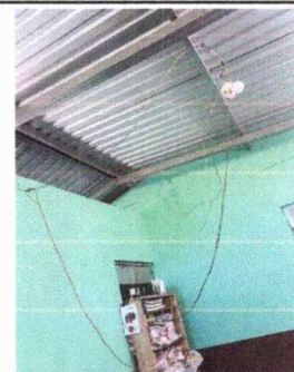
Foto 12: Sustitución del cableado de energía eléctrica del aula 3
