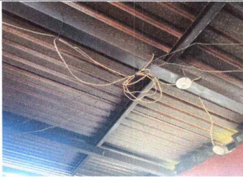
Foto 15: Sustitución del cableado de energía eléctrica de la cocina
