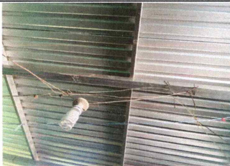
Foto 11: Sustitución del cableado de energía eléctrica del aula 2
