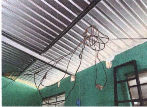
Foto 14: Sustitución del cableado de energía eléctrica del aula 6
