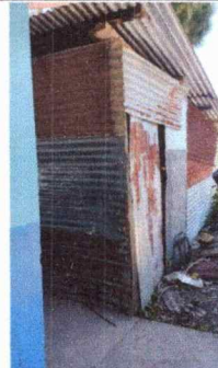
Foto 18: Reparación de bodega
