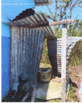
Foto 19: Sustitución de letrina
