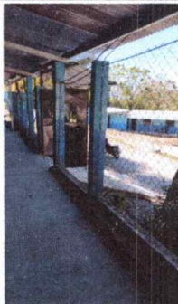
Foto 17: Sustitución de malla perimetral por muro perimetral de las aulas: 1, 2 y 3
