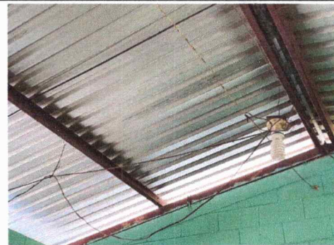
Foto 10: Sustitución del cableado de energía eléctrica del aula 1
