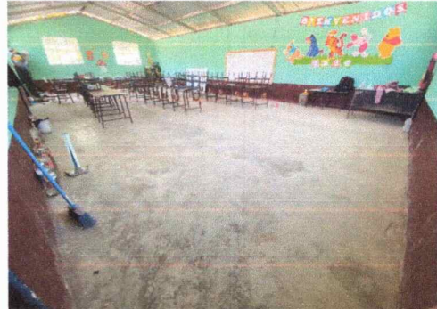
Foto 4: Sustitución de piso de torta por piso cerámico del aula 4
