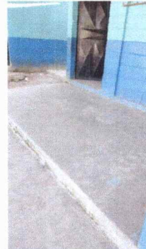
Foto 16: Sustitución de piso de torta por piso cerámico del corredor del aula 1
