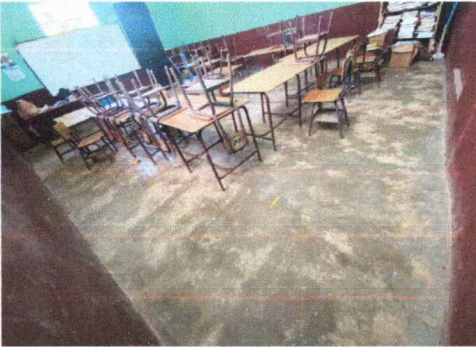
Foto 3: Sustitución de piso de torta por piso cerámico del aula 3
