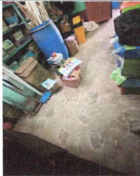
Foto 9: Sustitución de piso de torta por piso cerámico de la Dirección
